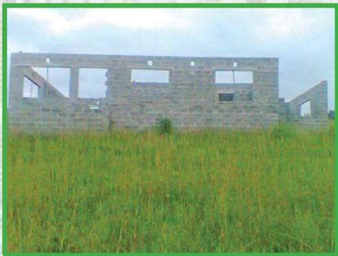
Portia's huis in aanbouw.
